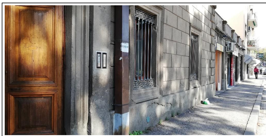
Foto 02 - Prospetto esterno del fabbricato, particolare discendente contornato da scatolare metallico
